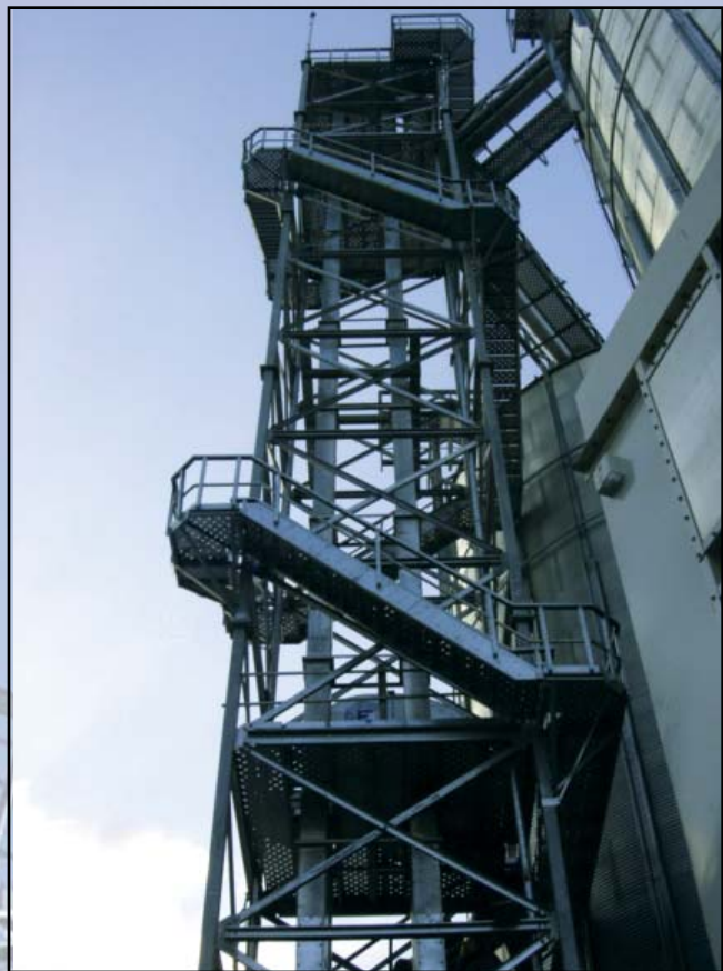
Опорные башни норий разрабатываются с укомплектованием спиральными лестницами и платформами.
