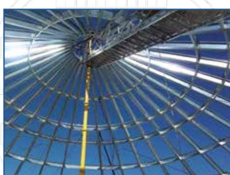
Les toits des silos et réservoirs de diamètre 39' (11,89 m) et 42' (12,80 m) ont un anneau tubulaire de support avec des connecteurs extensibles attachés à l'extérieur du toit, à mi-chemin entre l'avant-toit et l'anneau. L'anneau de support ajoute une certaine résistance à la structure du toit. Ces toits sont aussi équipés de 36 nervures de support.
